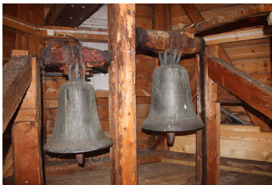
Nyeklokkene frå 1985. Den minste, til høgre, blir no brukt til enkeltslag og i samspel med den største. Vi ser motoren og den elektriske hammaren på storeklokka til venstre.
