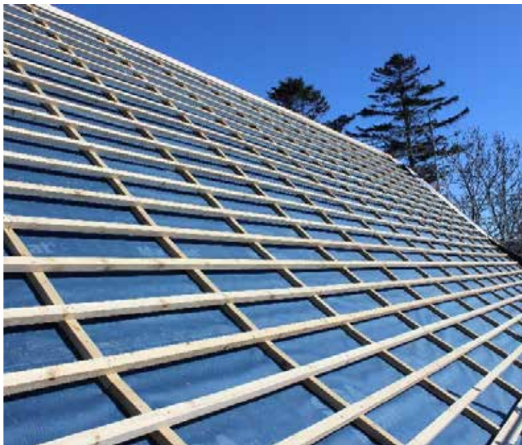
Med større lekter blir det meir luft under hellene og alt turkar fortare opp etter ein fuktig hauststorm.
